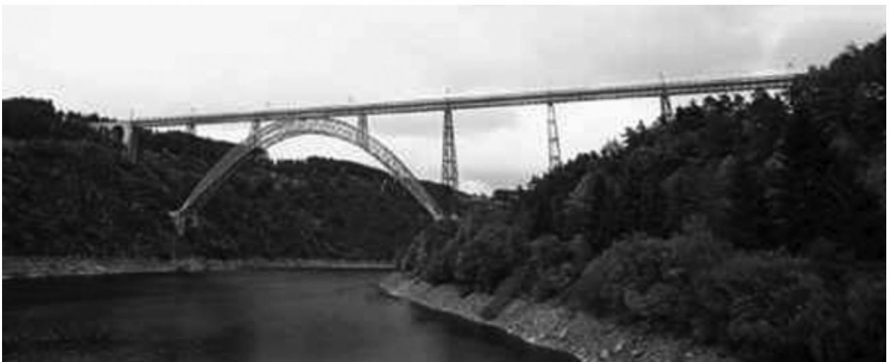
El viaducte de Garabit (Cantal)
