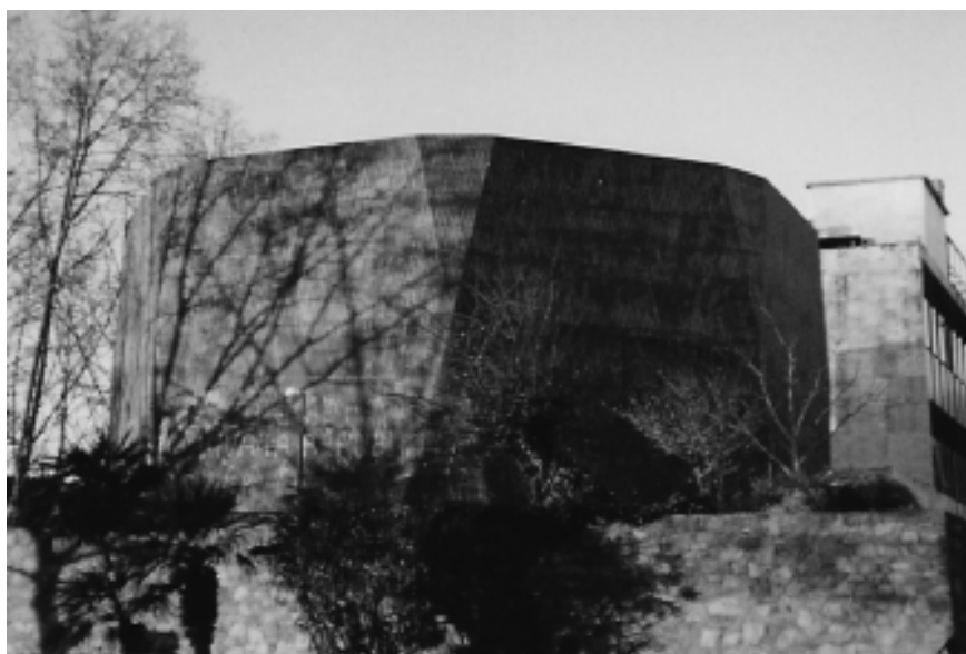
L'edifici de contenció del reactor nuclear Argos (Foto F.B.)
