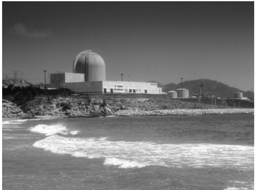
Central nuclear de Vandellòs
